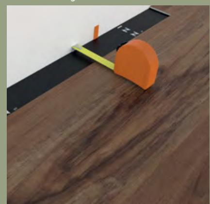
**Paso 10:** Última fila. El ancho mínimo de la última tabla no debe ser MENOR de 2" (5mm) de ancho. Coloque un separador antes de medir. Corte los paneles a lo largo y pegue los extremos cortos.
