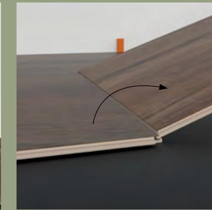
**Paso 8a:** Segunda tabla, segunda fila. Coloque el panel en ángulo en la ranura de la fila anterior asegurándose de que el extremo del panel esté apretado / alineado con el extremo corto del panel anterior.
