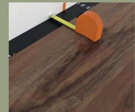
**Étape 10:** Dernière ligne. La largeur minimale de la dernière planche ne doit PAS être inférieure à 2 po de largeur. Mettre une entretoise avant de mesurer Couper les panneaux dans le sens de la longueur et coller les extrémités courtes.
