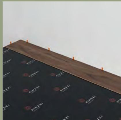
**Paso 1:** Primer tablón, primera fila. Coloque un espaciador de 3/8" (9,525mm) de grosor a la izquierda y coloque la tabla contra la pared.
