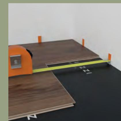
**Paso 4:** Al final de la primera fila, coloque un espaciador de 3/8" (9,525 mm) en la pared y mida la longitud del último tablón para que encaje.
