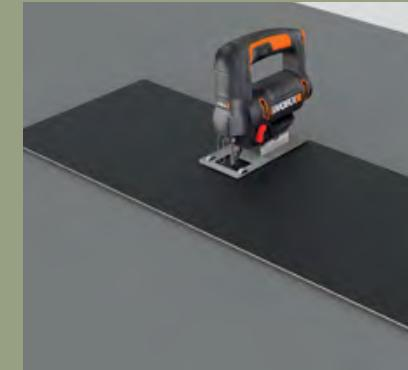
**Étape 5:** Coupez avec une scie sauteuse, une scie à main, une scie à chantourner ou un couteau à guillotine. Ensuite, enclenchez le revêtement de sol - comme pour marquer et casser une cloison sèche.
