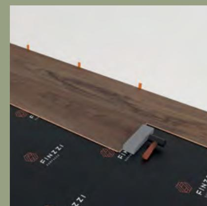
**Paso 8c:** El producto está correctamente bloqueado cuando las dos tablas están al ras en la parte superior. Termine de instalar este tablón golpeándolo con un taco de goma en el lado largo para garantizar una instalación segura.
