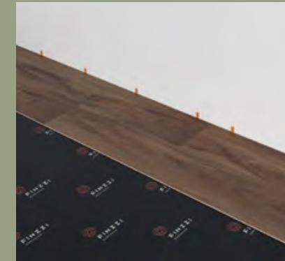
**Étape 6:** À partir de la deuxième rangée, la première planche doit avoir une longueur minimale de 10 po (254 mm). Placez une entretoise 3/8 (9,525 mm) contre le mur et mesurez la dernière pièce. Si elle est inférieure à 10 " (254 mm), une nouvelle pièce de départ doit être utilisée. Insérez à un angle dans la rangée précédente et tapez (sur le côté long) en utilisant un bloc de taraudage jusqu'à plat.
