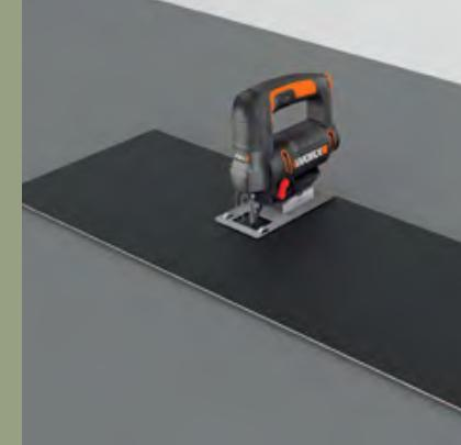
**Paso 5:** Corte con una sierra de calar, sierra de mano, sierra de corte o cortador de guillotina. Luego, rompa el suelo, de manera similar a los paneles de yeso.
