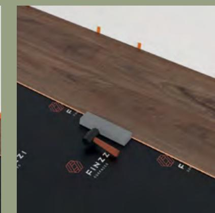
**Paso 9:** Despues de 2-3 filas. Ajuste la distancia a la pared frontal colocando espaciadores de 3/8" (9,525 mm) en las paredes laterales y la pared del extremo. Coloque un separador antes de medir. Corte los paneles a lo largo y pegue los extremos cortos.
