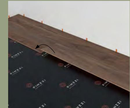
**Étape 8a:** Deuxième planche, deuxième rangée. Placez le panneau à un angle dans la rainure de la rangée précédente en vous assurant que l'extrémité du panneau est serrée / affleurante à l'extrémité courte du panneau précédent.
