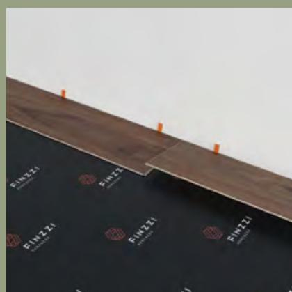
**Paso 3:** Doba el panel hacia abajo en un solo movimiento de acción. Luego coloque un espaciador de 3/8" (9,525 mm) en la pared y mida la longitud hacia abajo en el extremo corto que acaba de instalar hasta que haga clic.
