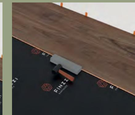
**Étape 9:** Après 2-3 lignes. Ajustez la distance par rapport au mur avant en plaçant des entretoises de 3/8 po (9,525 mm) sur les murs latéraux et le mur du fond. Une fois l'ajustement effectué contre le mur principal, continuez à installer jusqu'à la dernière rangée.
